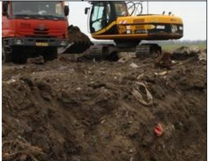
Hulladékprizma kialakítása 3.
