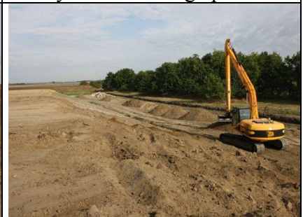
Fedő talajréteg építése 1.
