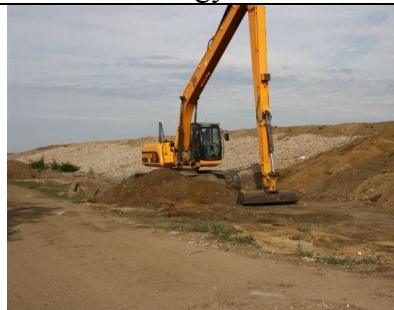
Gyökérfárási réteg elfedése
