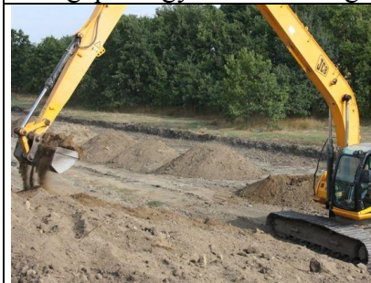
Fedő talajréteg építése 2.
