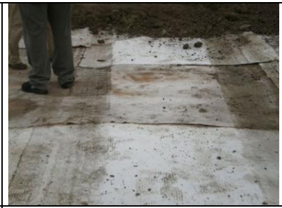
Geotextília:Secudrain,Bentofix
