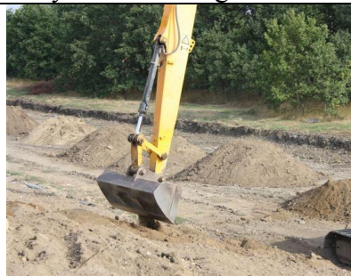
Fedő talajréteg építése 3.
