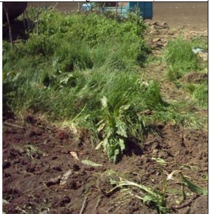
Terület előkészítése, humuszréteg leszedése
