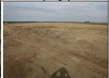
Megépített fedő talajréteg
