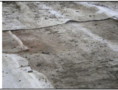
Geo textíliák leterítése
