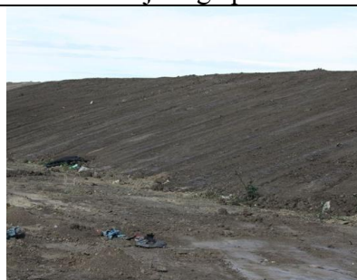
Megépített vegetációs talajréteg
