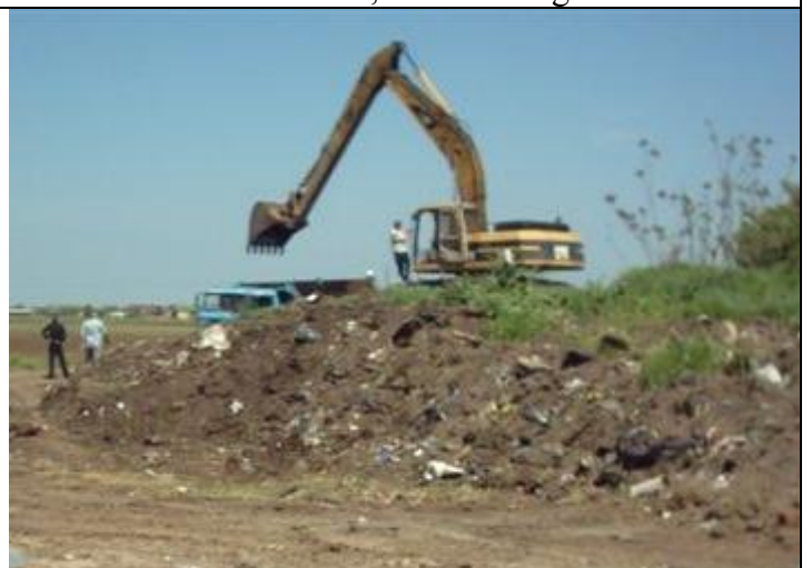
Hulladékdepónia áthalmozása
