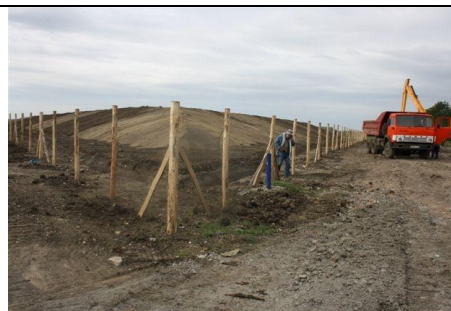
Kerítésoszlopok beépítése
