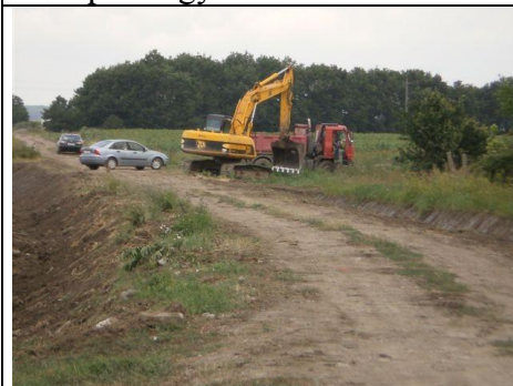
A hulladéklerakó feltáró útját is stabilizálták a projekttel együtt
