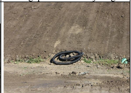
Csapadékvíz kivezető dréncső
