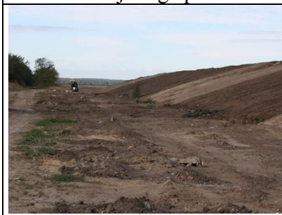
Vegetációs talajréteg építése
