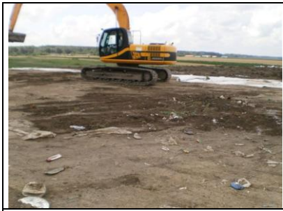
Kiegyenlítő talajréteg készítés
